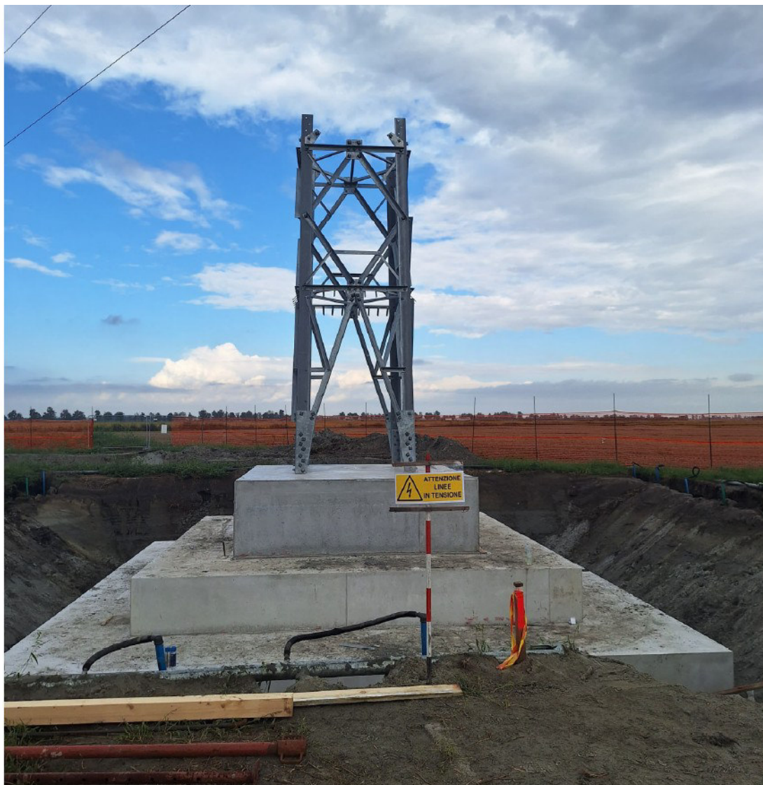
Figura 4.52: Esempio fondazione monoblocco
